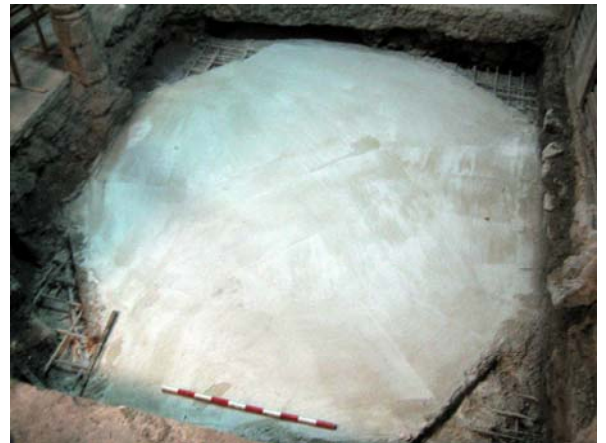
FOTO 16. Rebliment de formigó realitzat a l'interior del sondeig 1.
